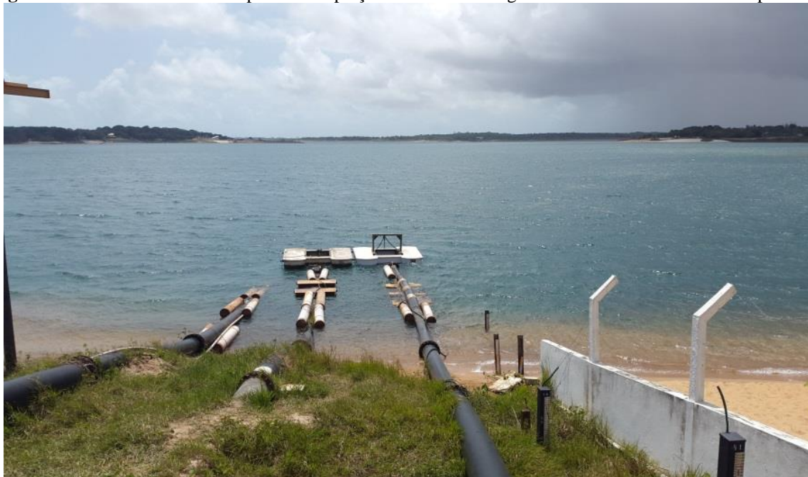
Figura 3.26 -Vulnerabilidade do ponto de captação do Sistema Integrado da Adutora Monsenhor Expedito.
