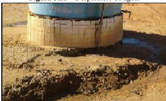
Figura 3.21 – Desperdício de água.
