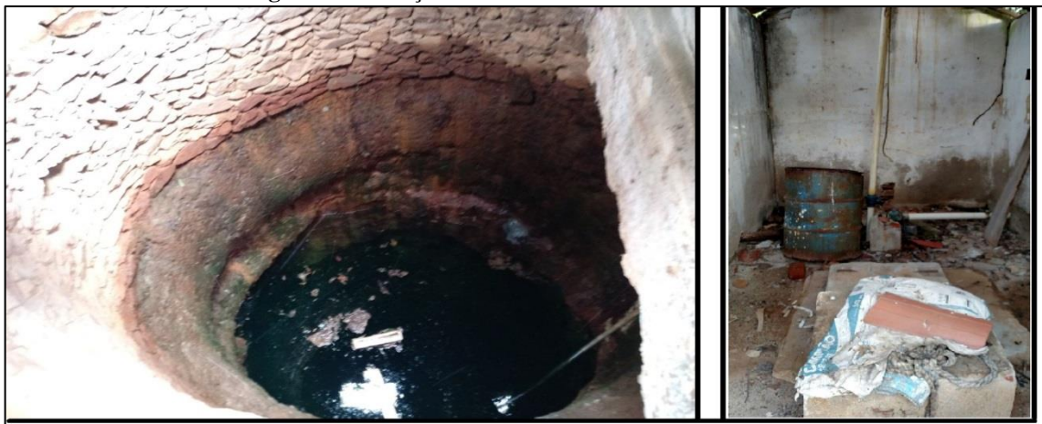
Figura 3.25 - Poço escavado e sistema de bombeamento
