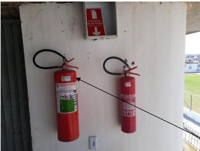
Extintores vencidos e despressurizados, além de identificação insuficiente.
