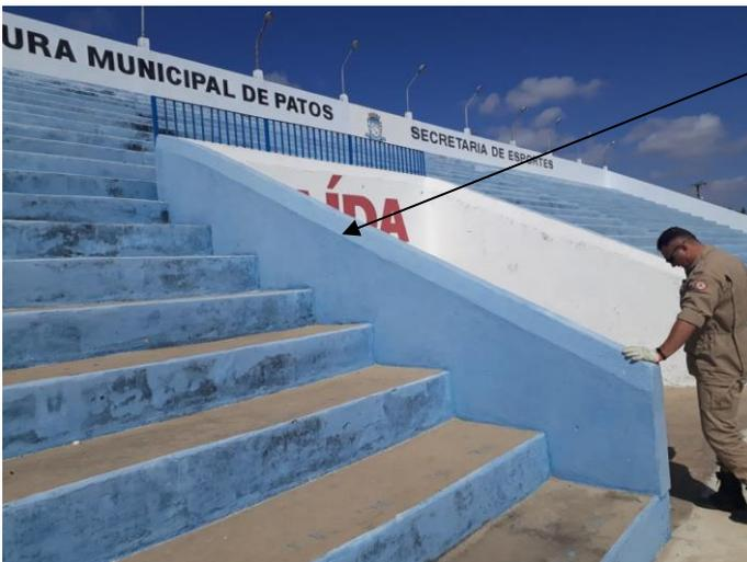
Guarda-corpo da arquibancada com altura inferior a 1,10 metros.
