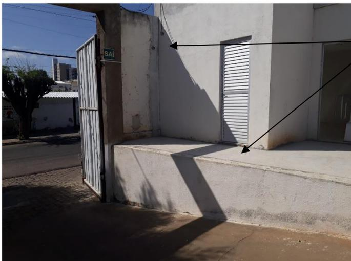
Entrada (lado NUMOL): Sem guarda-corpo e fiação exposta
