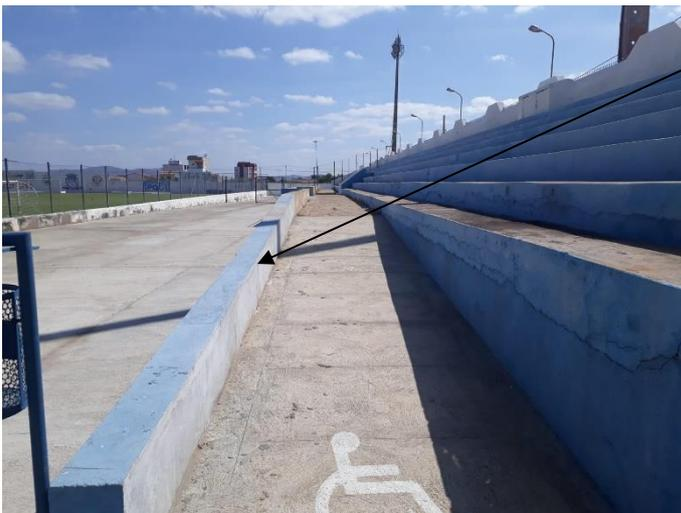
Rampa de acesso a deficientes físicos com altura inferior a 1,10 metros.
